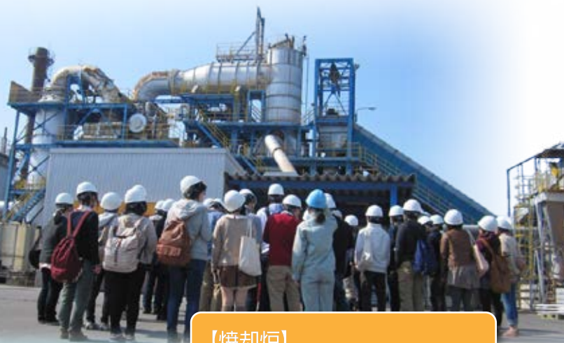
【焼却炉】 高～い焼却炉を見上げた後は、 炉の中を覗いて頂きました。
