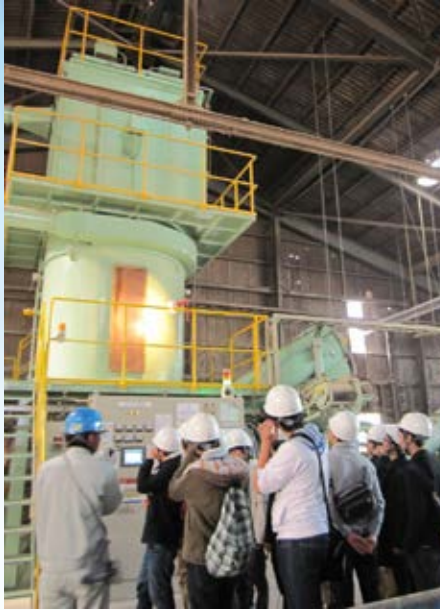
【発電機】 小さな箱の形の設備・・・焼却炉の熱を利用して、工場で使用する約半分の電気を発電してしまう優れたものです。皆さんビックリ!
