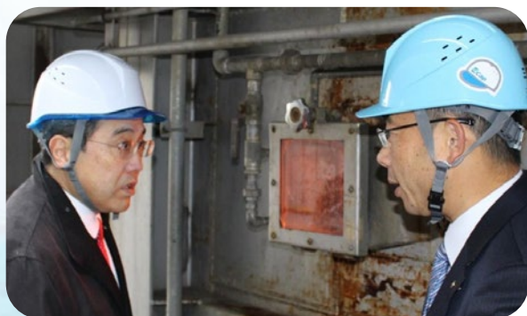
焼却炉内を覗いて頂きました。
