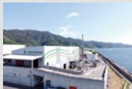
ウエストバイオマス工場
