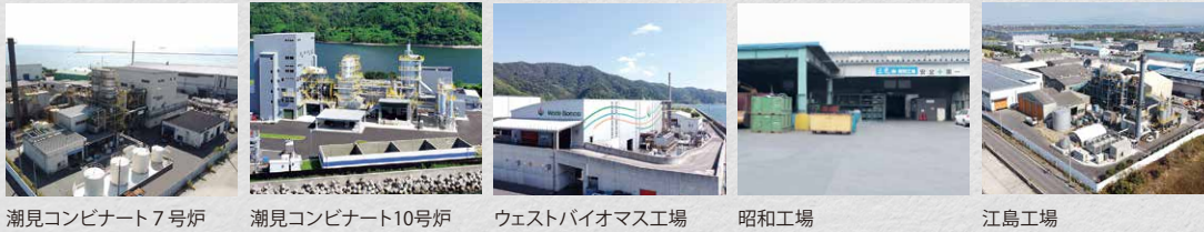
潮見コンビナート7号炉 潮見コンビナート10号炉 ウェストバイオマス工場 昭和工場 江島工場
