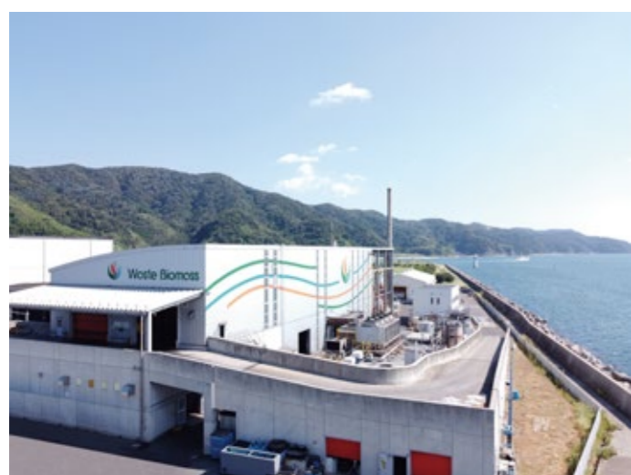
■ 潮見コンビナート ウェストバイオマス工場
